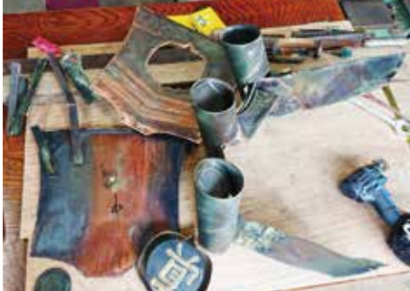
▲鬼を解体して溶接部を磨き、ゆがみを直します
